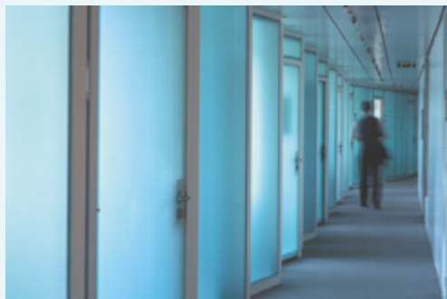
▲ Kwas fluorowodorowy służy do trawienia szkła. Dzięki temu te drzwi są matowe i nieprzezroczyste. Źródło ilustracji: Matelux acid-etched glass, reprodukcja za zezwoleniem AGC Flat Glass UK
