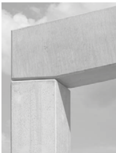
Rys. 26.250. Przykład oparcia wężara na słupie skrajnym z zastosowaniem ukośnego podcięcia wężara na podporze
