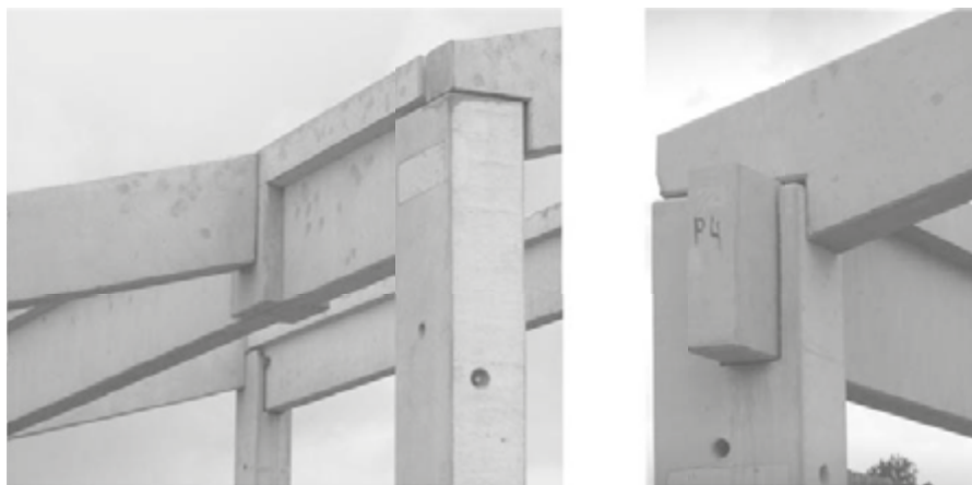
Rys. 26.274. Przykłady elementów konstrukcyjnych na słupach narożnych
