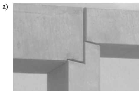
Rys. 26.263. Przykłady oparcia na słupie skrajnym wiązarów o różnej wysokości i o różnym nachyleniu
