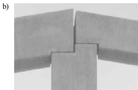
Rys. 26.263. Przykłady oparcia na słupie skrajnym wiązarów o różnej wysokości i o różnym nachyleniu
