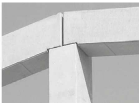
Rys. 26.261. Oparcie wiązarów na słupie wewnętrznym: a) w przypadku wąskich dźwigarów b = 0,3 m, b) w przypadku szerokich płaszczyzn oparcia b = 0,5 m; 1 – pręt \phi 20 mm, 2 – rura karbowana \phi 60 mm, 3 – podkładka elastomerowa, 4 – zaprawa ekspansyjna
